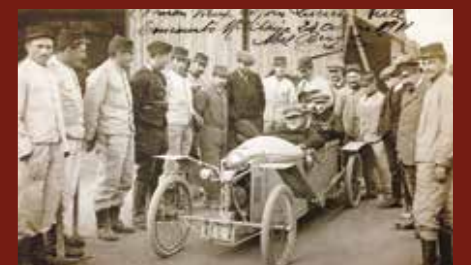
Bédélia Type BD2 de course, elle est équipée d'un moteur Bédélia bicylindre 10 HP alésage 80 x 100 mm. Vendue 2200 Frs.
