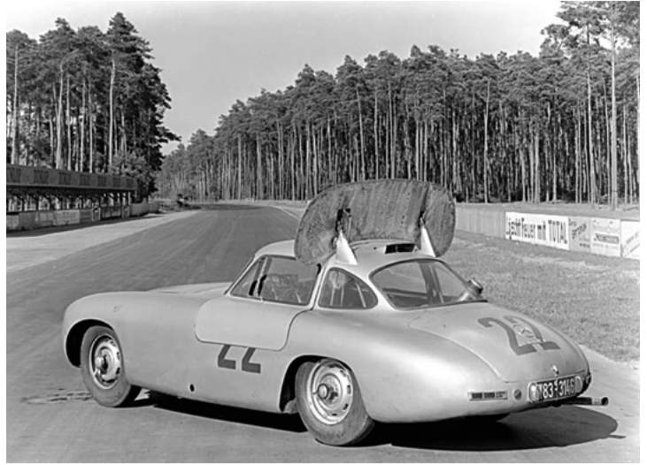
Mercedes qui prépare le Mans teste en 1952 un dispositif aérodynamique qui se lève au freinage pour accentuer le ralentissement de la voiture et épargner les freins.
